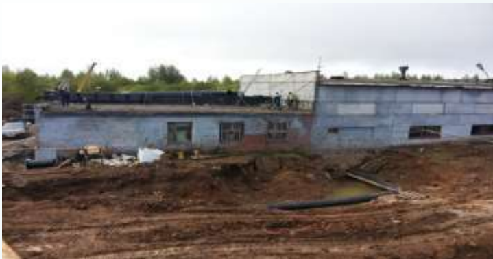
Здание ВНС в начале производства работ по реконструкции
