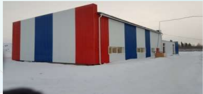
Здание ВНС после производства работ по реконструкции
